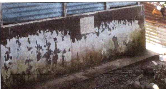
FOTO 6: Reparacion muros exteriores e interiores (MODULO AULA II)
