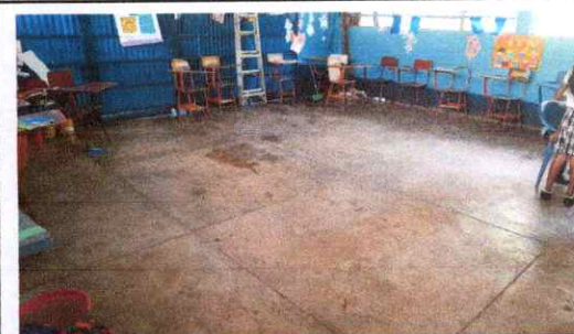
FOTO 4: Sustrucción de piso de cemento liquido por piso ceramico (modulo de aula I)
