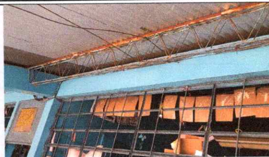
FOTO 2: Sustrucción de estructura de soporte de hierro de metal, por metal(modulo aula I)
